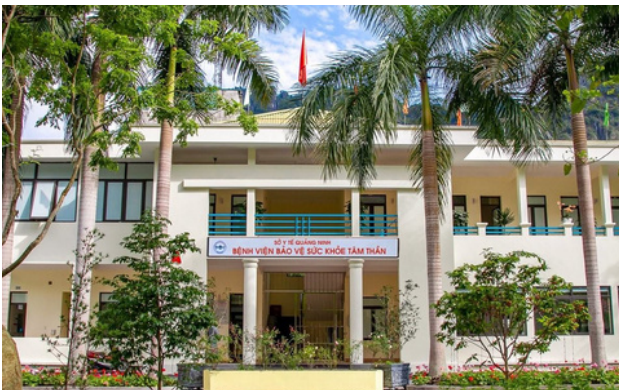
DỰ ÁN CẢI TẠO BỆNH VIỆN BẢO VỆ SỨC KHỎE TÂM THẦN TỈNH QUẢNG NINH
